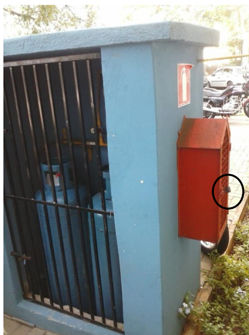
Figura 18 – Central GLP – Extintor bloqueado Fonte: Arquivo pessoal – 2013
