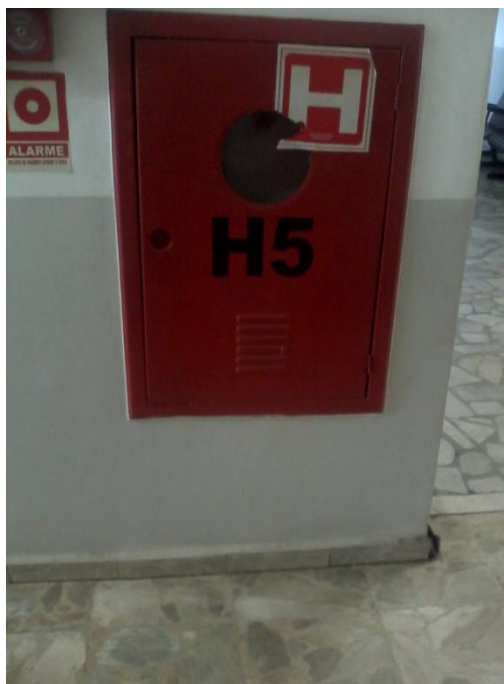
Figura 10 – Sinalização de hidrante inadequada Fonte: Arquivo pessoal - 2013
