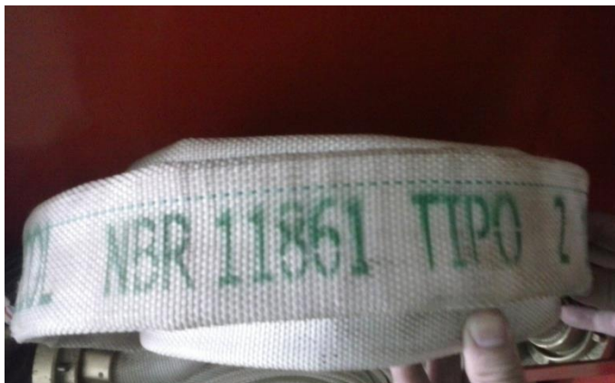
Figura 13 – Mangueira adequada à ABNT NBR 11861 Fonte: Arquivo pessoal - 2013
