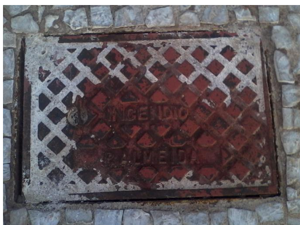
Figura 14 - Tampa do dispositivo de recalque Fonte: Arquivo pessoal - 2013
