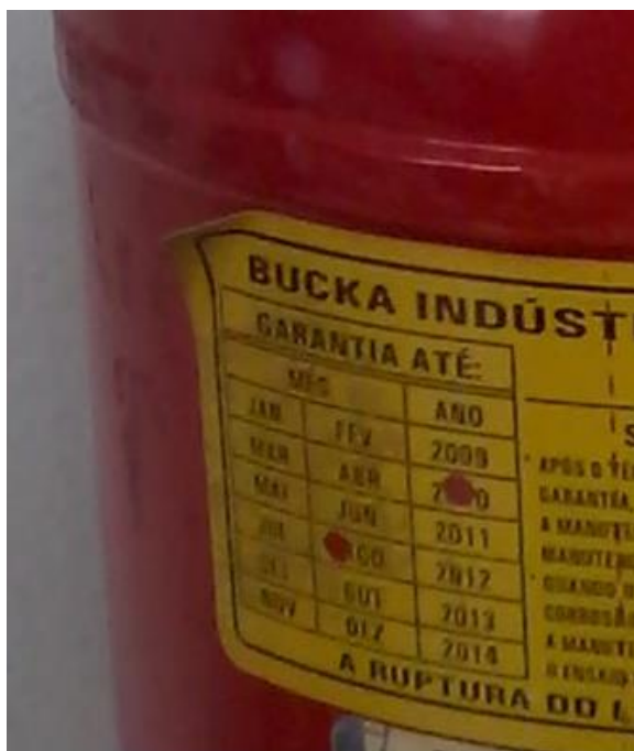
Figura 8 – Extintor vencido Fonte: Arquivo pessoal - 2013
