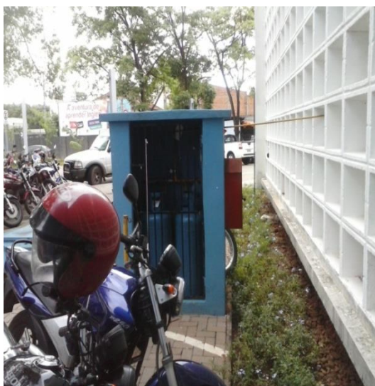
Figura 17 – Central GLP – Distância da fonte de ignição Fonte: Arquivo pessoal – 2013
